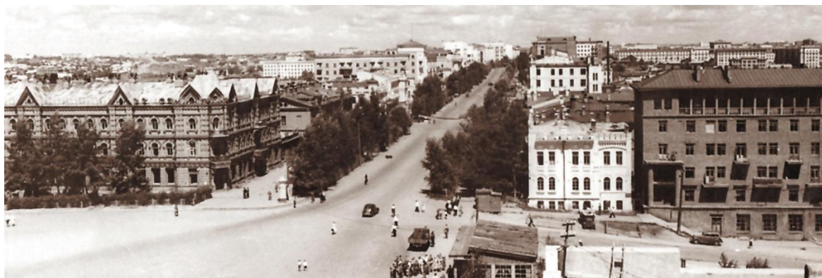
Рис.120. – Строится жилой дом специалистов Амурского речного пароходства. Фото 1946 г.
