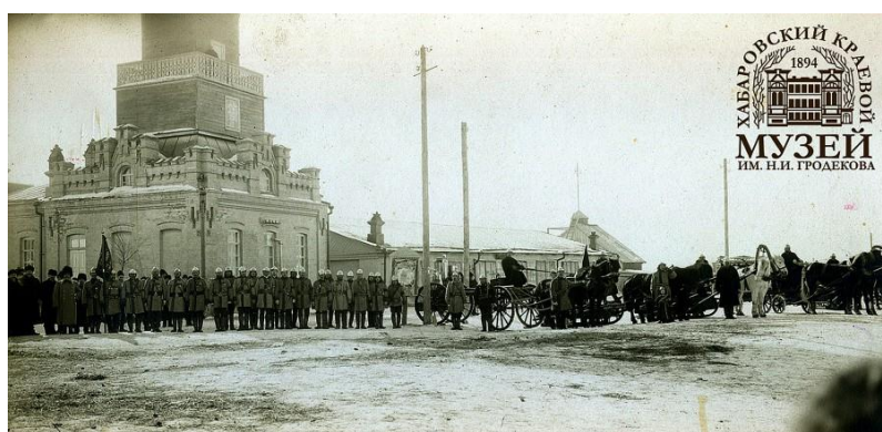
Рис.114. – Ул. Ленина – 33, здание вольной пожарной дружины
