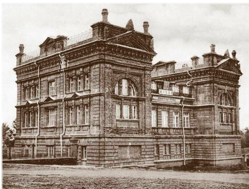
Рис.21. - Вход в музей сбоку, из пристройки за углом, на 2-й этаж.
