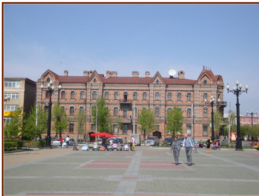
Рис.33. - Здание на ул. Муравьева – Амурского – 1, ДВГНБ.
