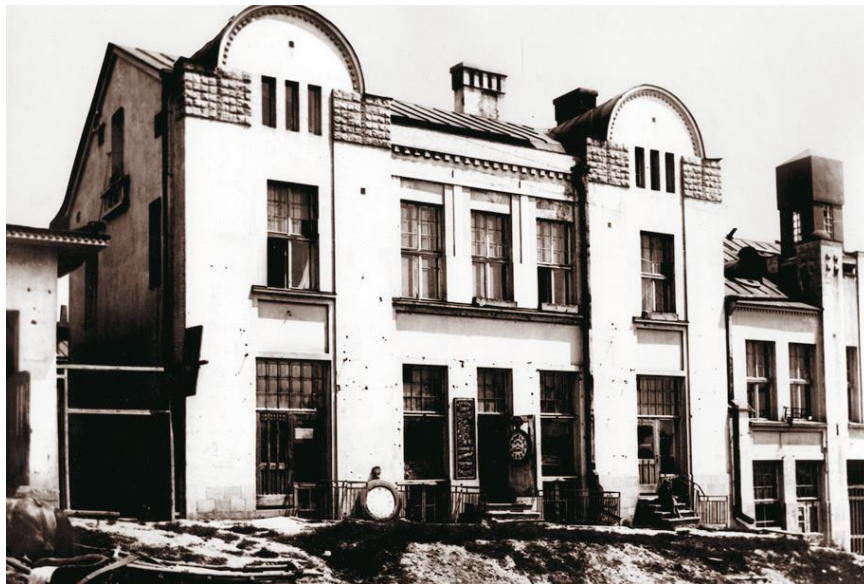
Рис. 70. – Комсомольская – 84, доходный дом Г. Г. Лухта, участок с 1901 года. Этаж ниже уровня земли.
