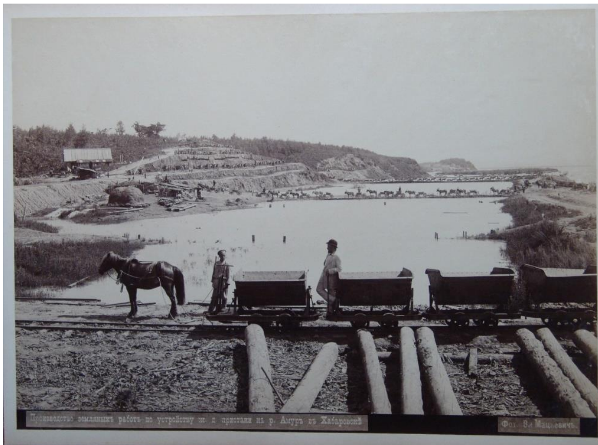
Рис.8. - Фото «Производство земляных работ по устройству железнодорожной пристани на реке Амур в Хабаровске».
