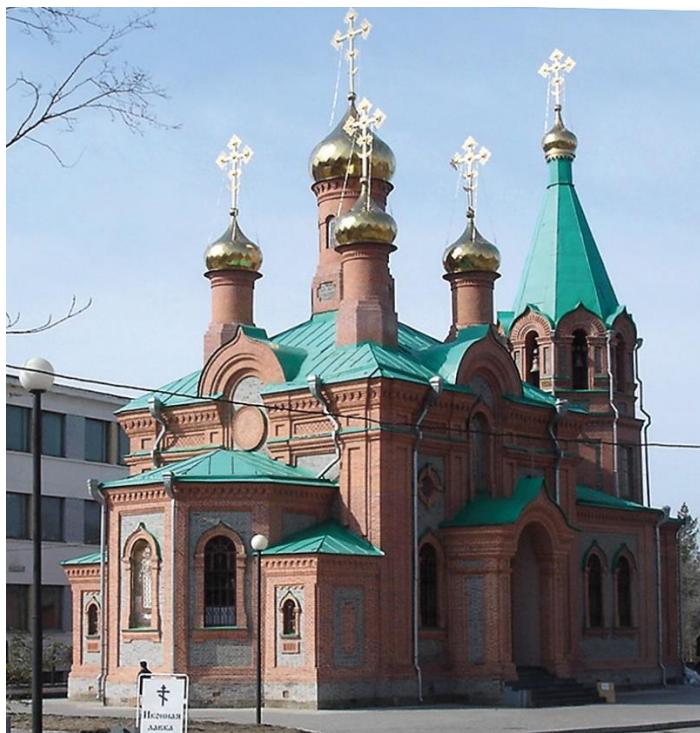
Рис.69. – Церковь Святителя Иннокентия Иркутского, 1898 г., ул. Тургенева, 73Б. Здание до и после реставрационно-восстановительных работ
